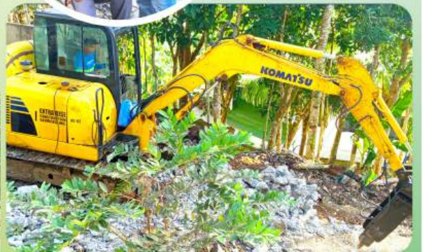
Ang dating matarik na kalsada ay sumailalim sa slope construction upang ito ay ligtas na madaanan.
