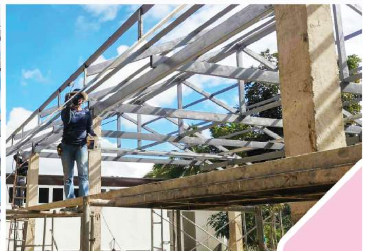
Nagkabit ng mga metal truss upang mapatibay ang estruktura ng bubong nito.
