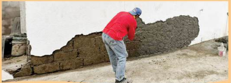
Ang bubong ng panambahan ay nilinis din dahil sa mga putol na sanga na nilipad dito. Ang pader na nasira ay pinalitadahang muli at isinaayos.
