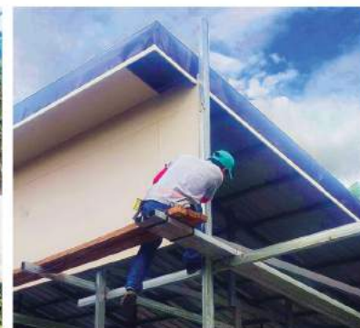
Ang bahagi ng bubong, kisame at palibot nito ay sinimulang ikabit. Ilang linggo pa at maaari na itong magamit ng mga bibisita rito.
