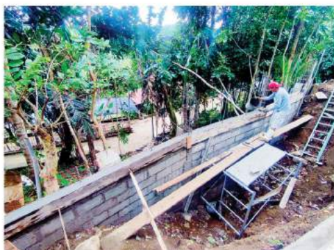
Matatapos na rin ang ginagawang bakod na nasira noong nakaraang bagyo. Ito ay proteksiyon para hindi na muling gumuho ang bahagi ng lupa rito.
